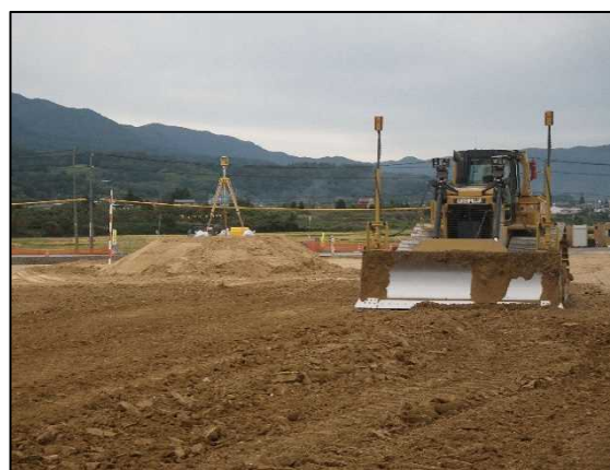
MCブルドーザによる敷均し
