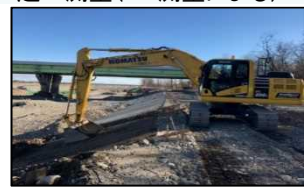
法面整形状況 (MCバックホウ)
