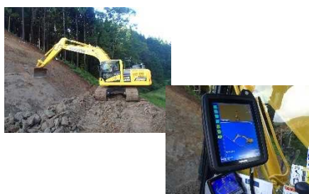
MCバックハウによる 切土法面整形
