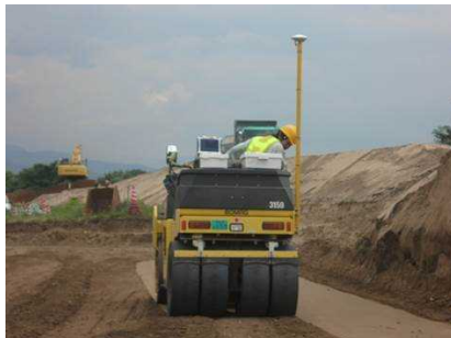
GNSSローラーによる転圧
