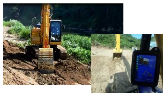
MCバックホウによる 掘削・切土法面整形
