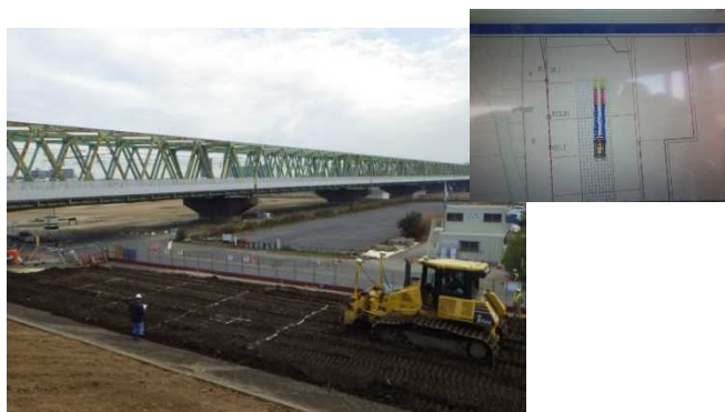
ブルドーザーにおけるICT施工状況 (12月20日撮影)
