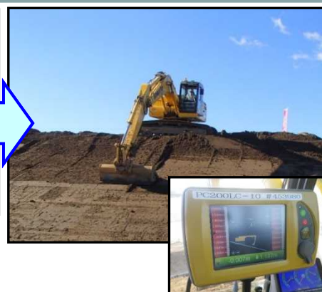
【MGバックホウによる法面整形】 仕上がり精度が大幅に向上
