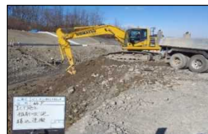
掘削状況 (MCバックホウ)
