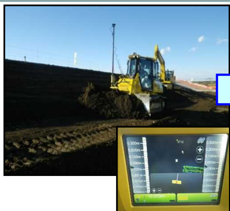
【MCブルドーザを用いた敷均し作業】 自動制御により、操作ミスの減少
