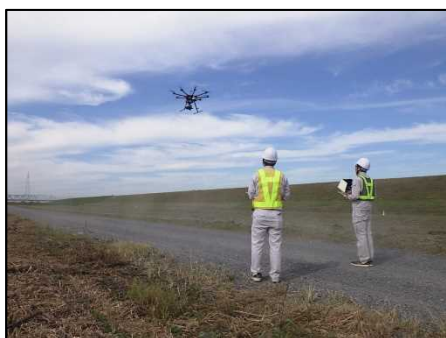
UAV(ドローン)起工測量
