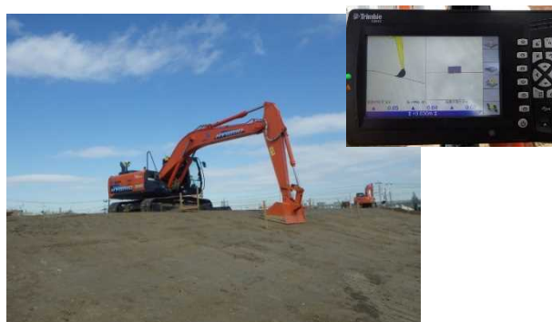
バックホウにおけるICT施工状況 (2月25日撮影)
