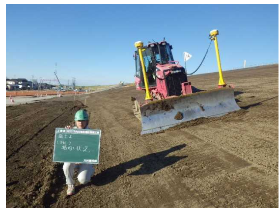
MCブルドーザ法面整形
