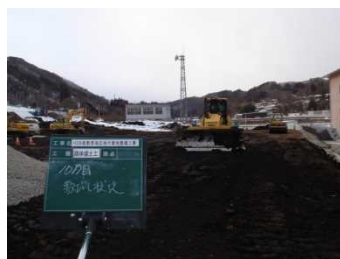
MCブルドーザによる 路体盛土敷均し状況
