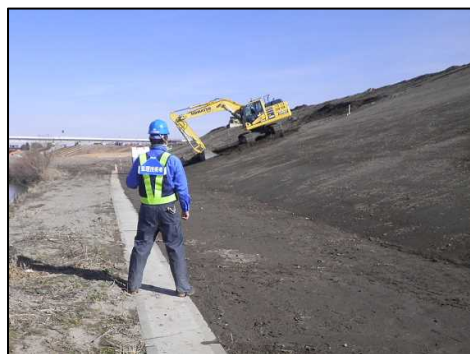
ICTバックホウ(MC)による法面整形
