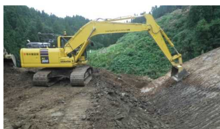
MGバックホウによる 切土法面整形
