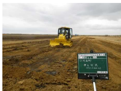
MCブルドーザによる 押土状況 10月25日撮影
