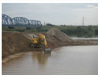
MCバックホウによる掘削
