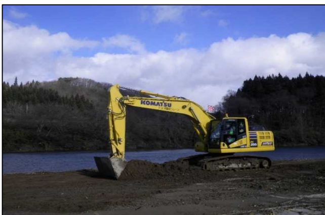
ICT(MC)バックホウによる掘削状況
