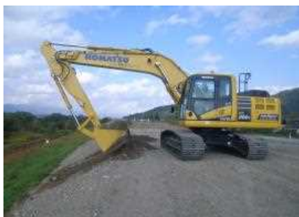
MCバックホウによる法面整形
