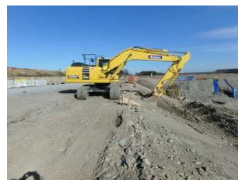
MCバックホーによる法面整形
