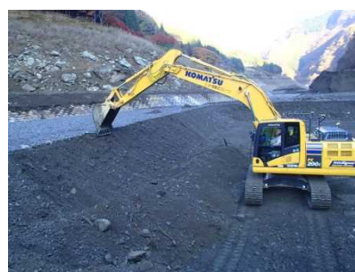
MCバックホウによる切土法面整形
