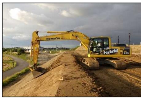
3DMGバックホウによる法面整形
