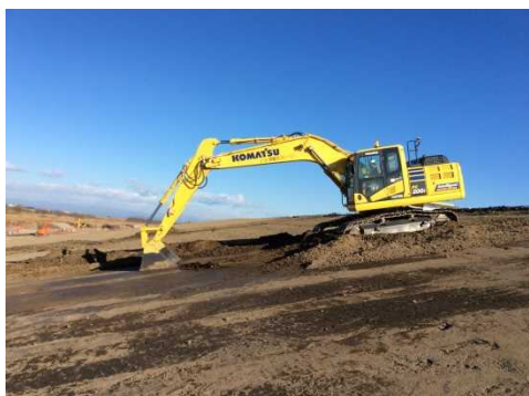
ICTバックホウによる法面整形
