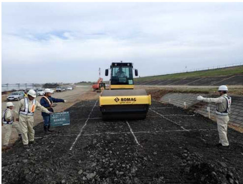
振動ローラ(締固め管理システム搭載)
